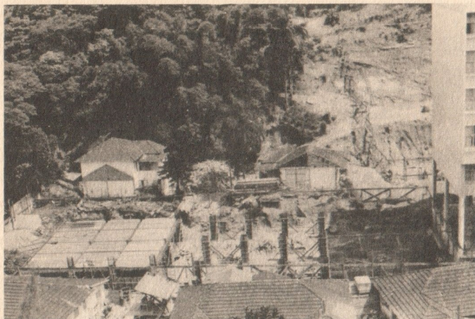
Obras do Instituto de Química e do Acelerador Atômico Van Graaff.
